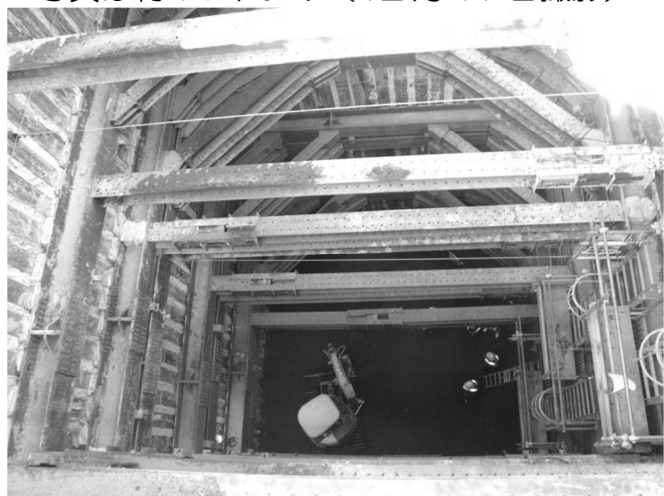
立坑をのぞき見る…思わず足がすくみます 深さ約 17 メートル（12 月 19 日撮影）
