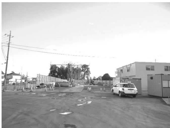
正面右が現場事務所、左奥に発進立坑 (12月17日撮影)
