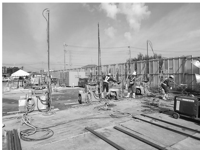
トンネル掘削のため地盤を強化しています (10月20日撮影)
