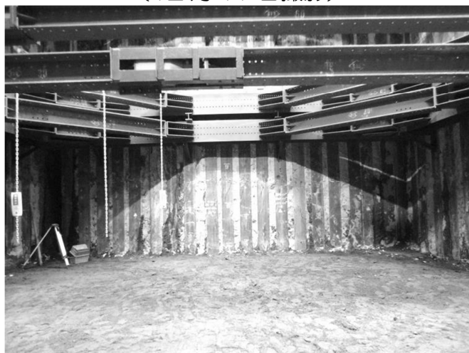
17.6 メートルまで掘削し、横方向へシールド 工法で進みます（12 月 19 日撮影）
